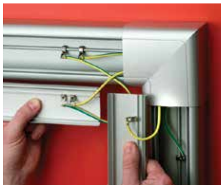
Количество монтируемых проводов заземления в плоском угле
