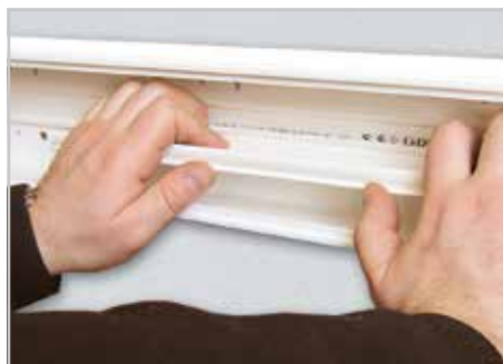
Разделитель защелкиванием устанавливается на направляющие дна короба
